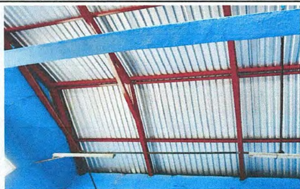
Foto 1: finalización del mejoramiento de lamina troqueleada calibre 26.
