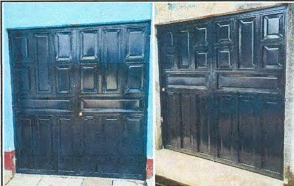
Foto 2: Mejoramiento de 2 portones de ingreso finalizado.
