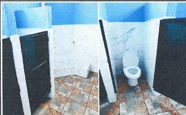
Foto 5: Finalización de área de baños, pintura de paredes, cambio de piso, puertas.
