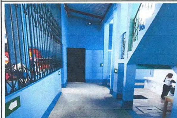
Foto 4: Mejoramiento de balcones y vidrios para ventanas.
